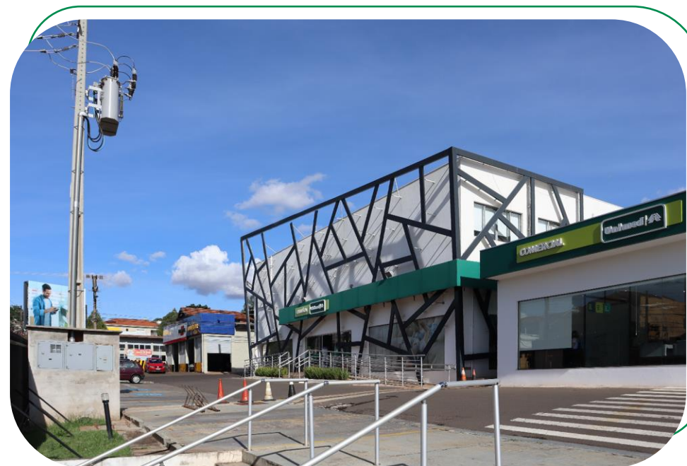
Readequação executada em maio
